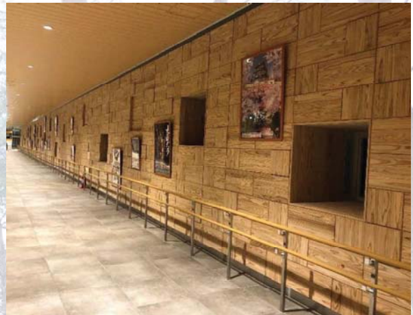
木造公共建築物（青森駅自由通路）
