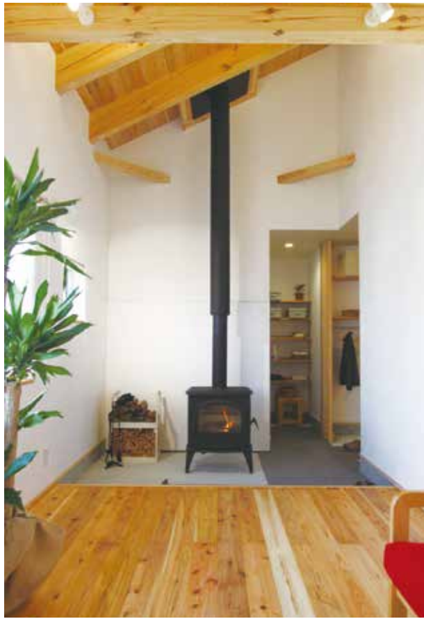
玄関土間の薪ストーブ1台で全室が暖まる
