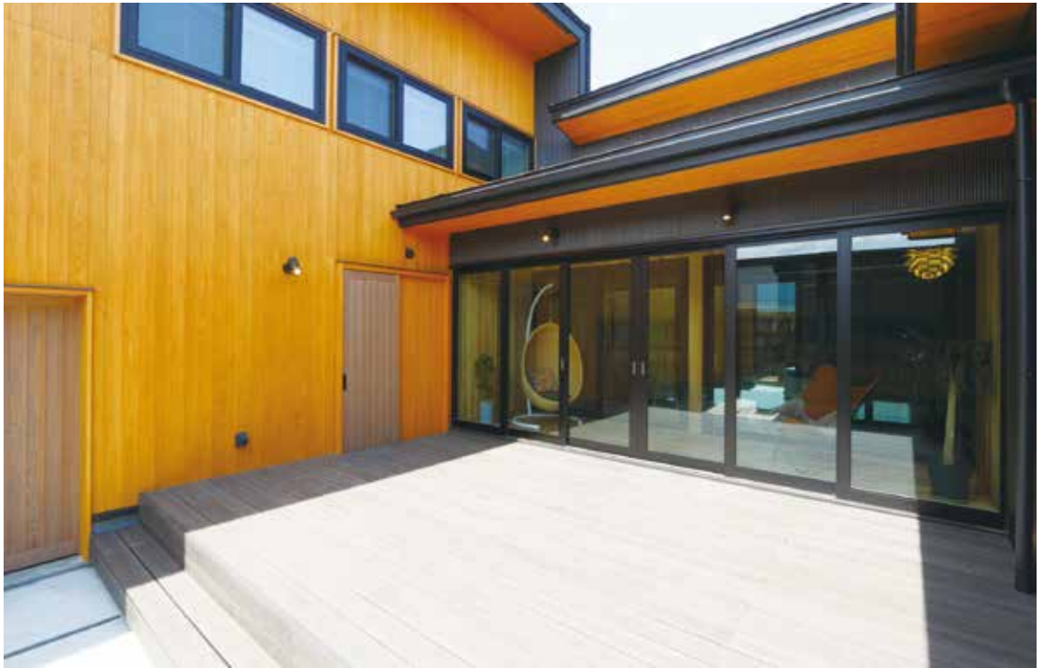
サンルームの外に設置された広々としたデッキテラス
