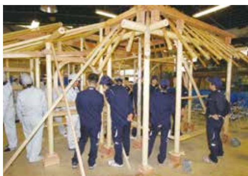
木材加工センターに仮組みされた「茶室」の構造見学会(2019年)
