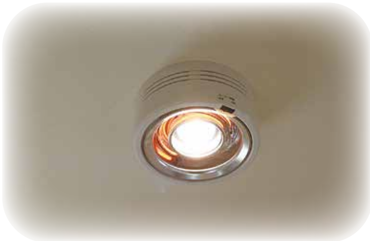
暖房を兼用した洗面所の照明器具。スイッチをつけてこの下に立つと頭部が暖まってくる。真ん中がライトで、その周りが熱くなるしくみ
