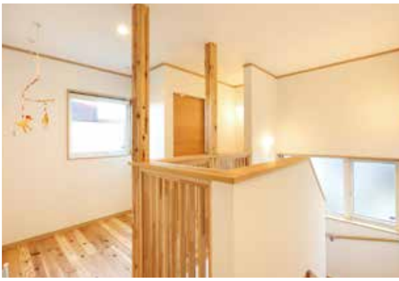
階段の腰壁を格子にして窓からの明かりを採り入れる細かな配慮
