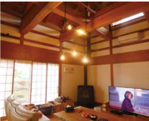
柱と鴨居が組み合う伝統構法の力強さが空間に安心感をもたらす
