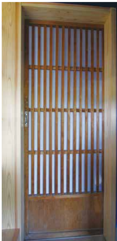
実家に仕舞われてあった格子戸を利用したトイレの引き戸
