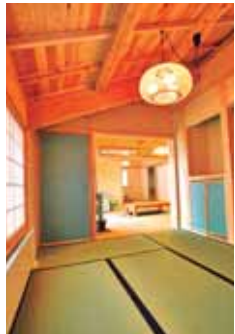
天井との一体感を求め建具にもスギ材を使用
