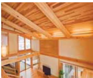
アカマツの登り梁が作り出すダイナミックな吹抜け
