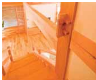
釘を使わないで組み上げた手すり
