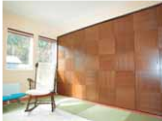
柱目を生かし市松模様に仕上げた収納扉
