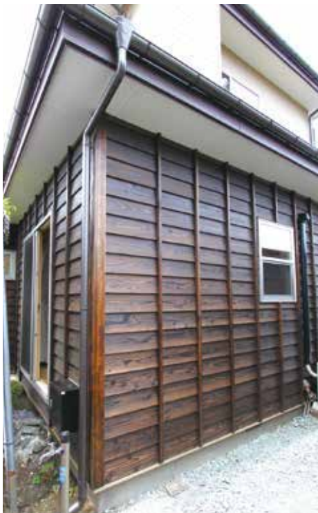
新しく張り替えられた板壁が古民家の佇まいを感じさせる
