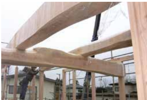
2016年11月下旬に上棟し、2017年5月の竣工に向けて現場は進んでいる
