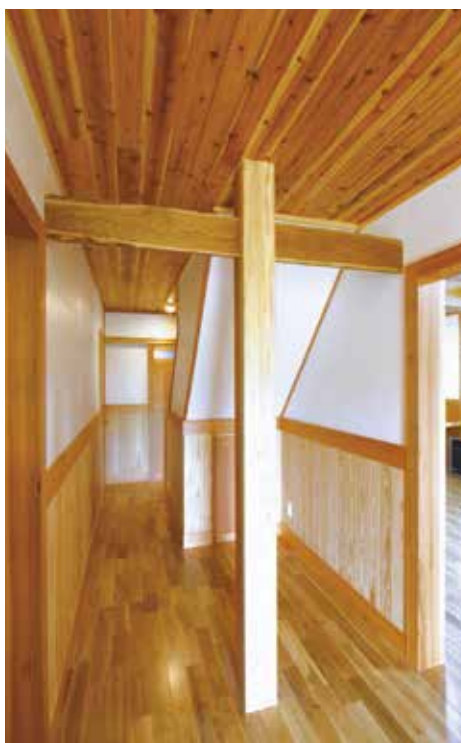
大工による手刻みで無垢の木の良さが生かされている
