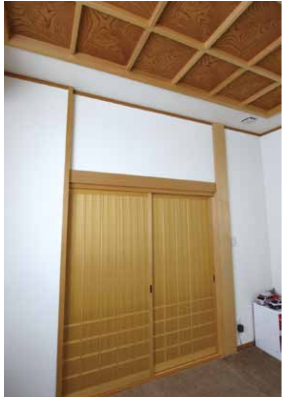
天井や壁、引き戸など、至るところに青森ヒバが使用されている
