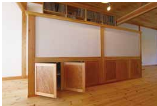
床を70cm上げたDJブースの下は収納スペースとなっている
