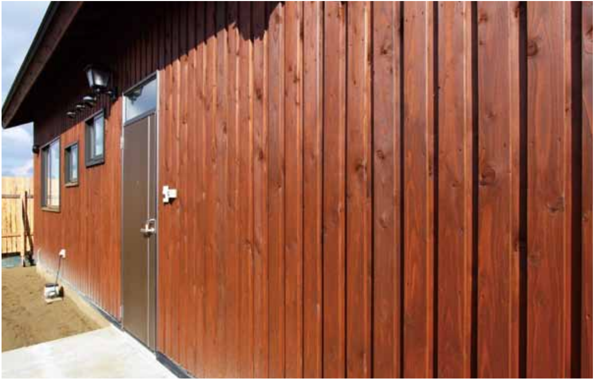
カラマツの板を1枚1枚手間をかけて張られた外壁
