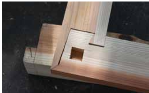
隠れた部分に活かされている宮大工ならではの“継手”の高度な技術(DJブースの土台)
