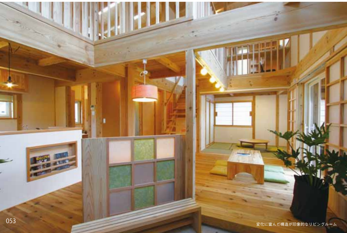
家のシンボルにもなっている8寸角のスギの大黒柱
