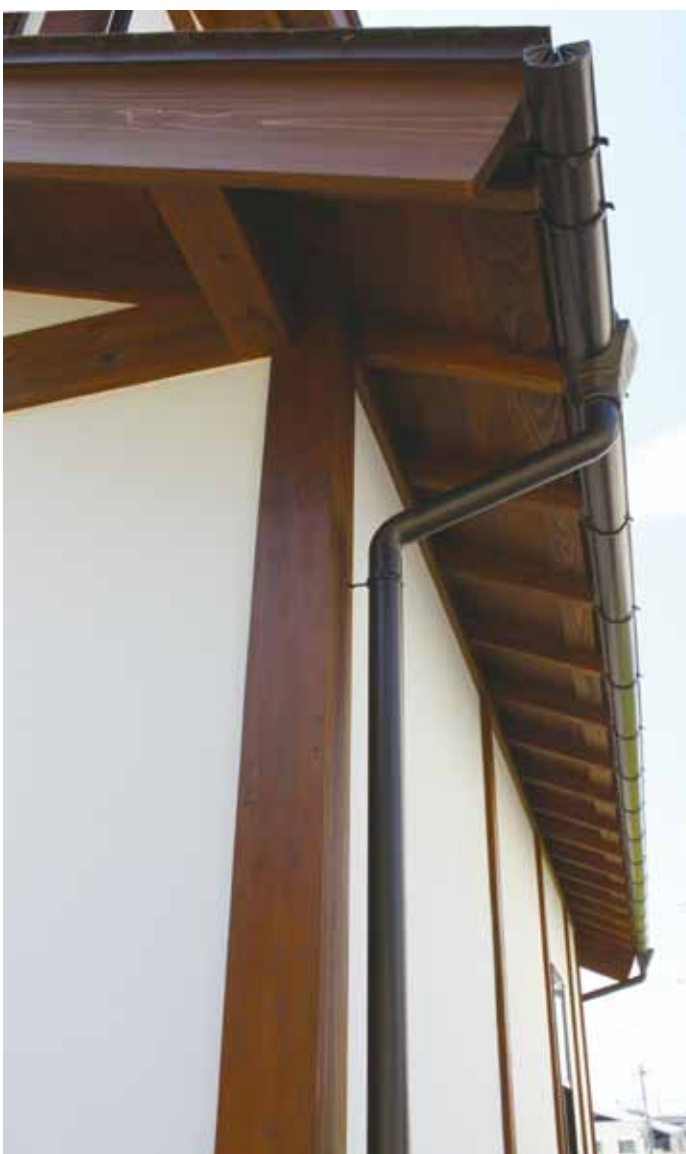
宮大工の技術が随所に活かされた屋根の軒先
