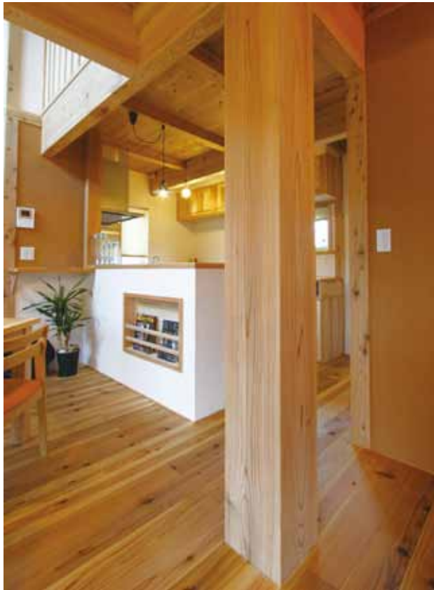
家のシンボルにもなっている8寸角のスギの大黒柱
