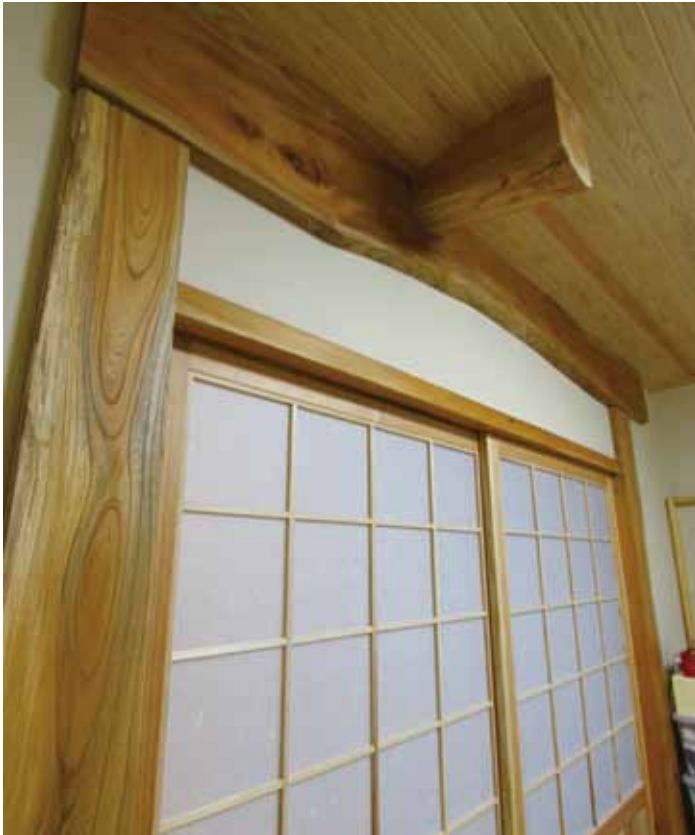
大工の高度な技術が光る日本古来の工法で組まれた梁
