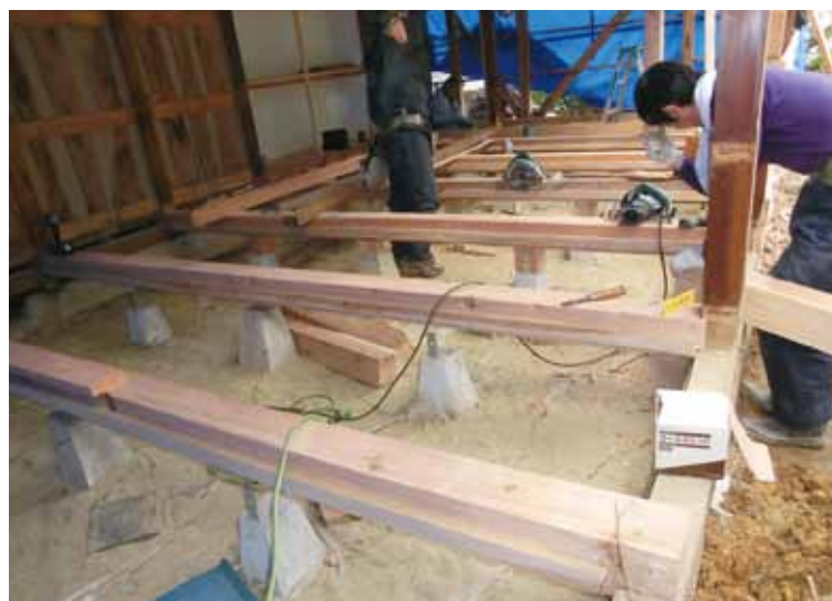
腐っていた大引を新しくするなど目に見えない部分も補強
