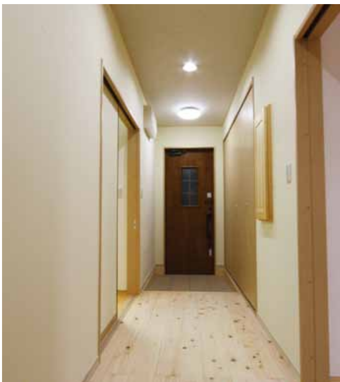
車椅子に対応して廊下の幅を広く取ってある
