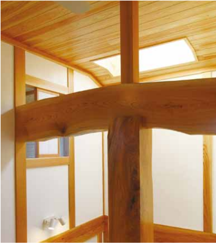
吹き抜け部分で力強く交差する大黒柱と梁は県産ケヤキを使用
