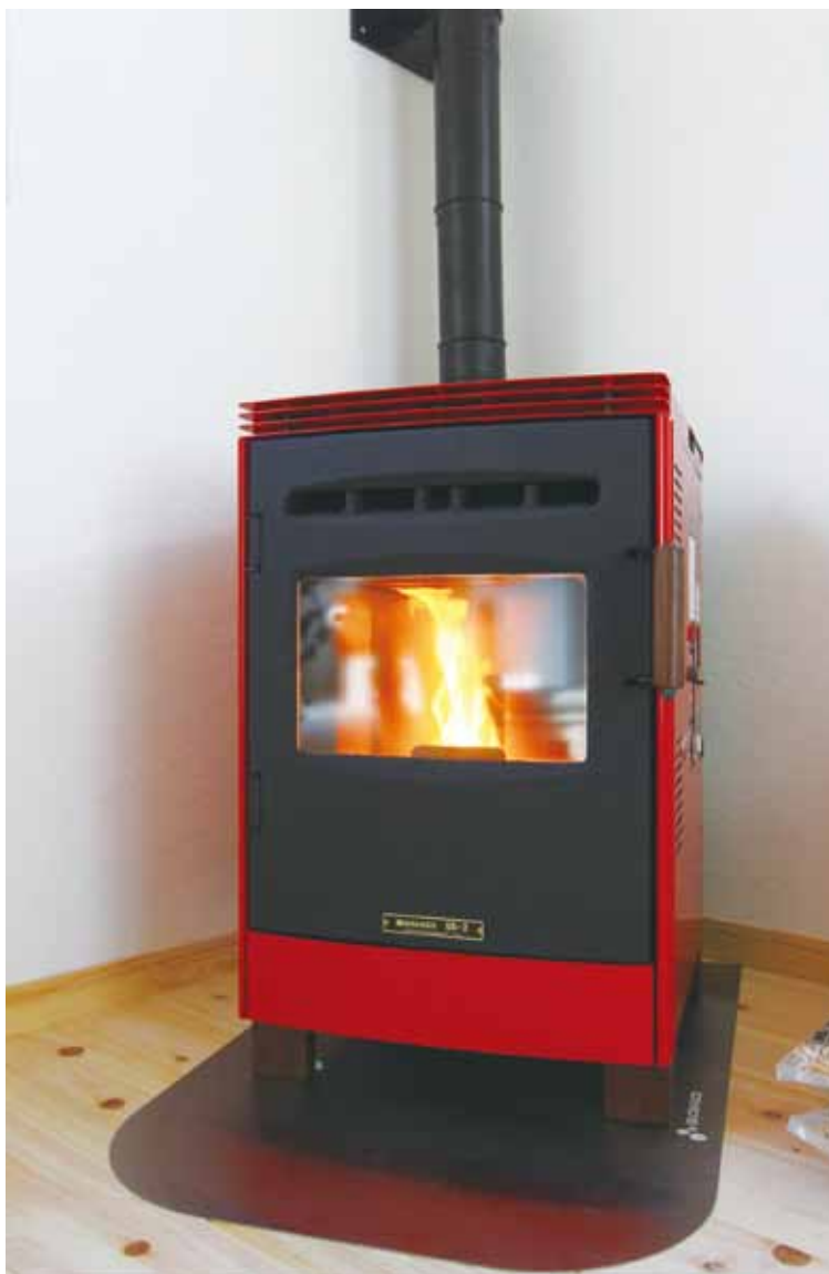
キッチンとダイニング、リビングの暖房はこのペレットストーブ1台でまかなわれる
