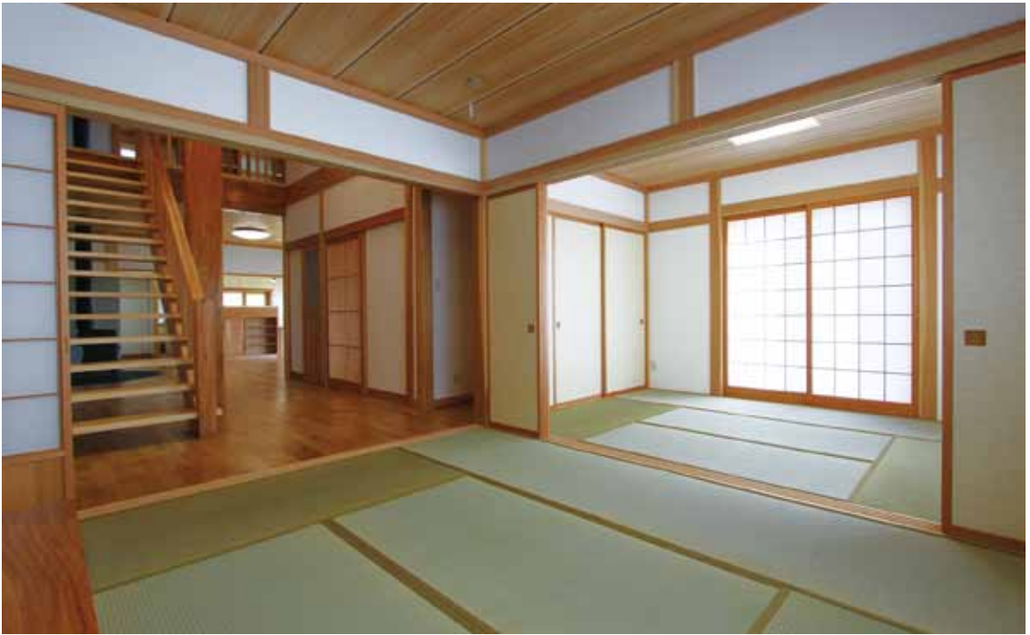
二間続きの仕切りを6枚戸にすることで広々とした開口を実現
