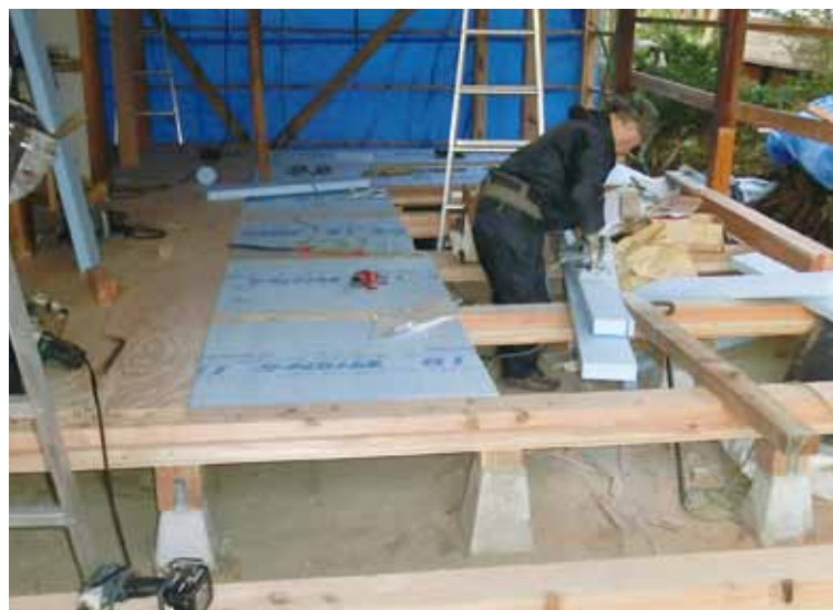
床に断熱材を敷くことで断熱・気密性は格段に改善された
