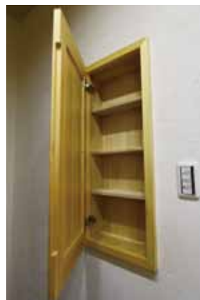
玄関内に取り付けられた木製のキーボックス (トイレ内にもペーパーボックスとして設置)
