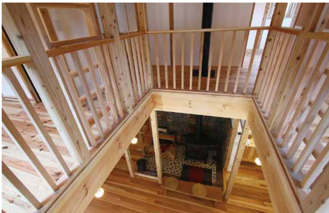
ストーブの暖かさが吹抜けを通して2階も暖める
