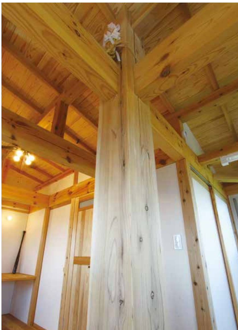
開放的な空間を引きしめている8寸角の大黒柱。三上様がチェンソーで伐倒したスギから製材した
