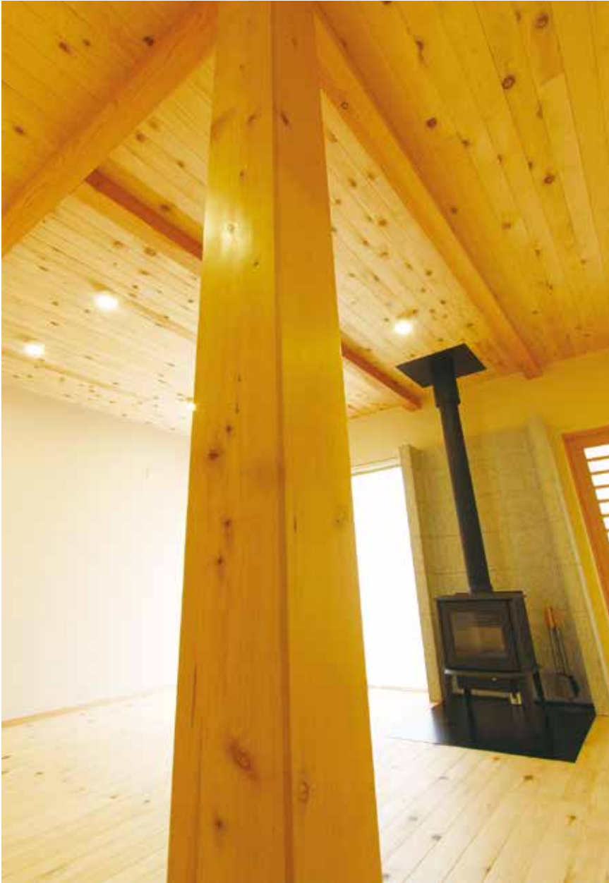
どっしりとした安心感を与えてリビングに立つ6寸角のヒバの大黒柱
