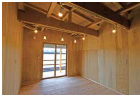
内装は合板をそのまま見せてシンプルな仕上げに
