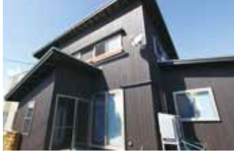
■建築場所／弘前市 ■県産材使用量／20.8㎡ ■県産材使用率／84.8% ■設計・施工者(応募者)／企業組合県木住 住所／青森市松原1丁目16-25 青森県森林組合会館2F・3F TEL.017-732-5333
