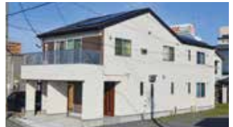
■建築場所／八戸市 ■県産材使用量／24.4㎡ ■県産材使用率／98.7% ■施工者(応募者)／株式会社建工 住所／三戸郡五戸町大字切谷内字淋代14-1 TEL.0178-21-3055 FAX.0178-21-3033 ■設計者／株式会社建工一級建築士事務所 住所／八戸市大字河原木字千刈田7-1 TEL.0178-21-3055
