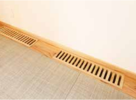
エアコンが送り込んだ暖気や冷気は、各部屋の床の格子のガラリから立ち上る
