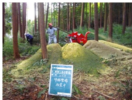
(使用する資機材の様子)
