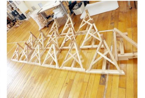
令和5年2月8日(水)に実技試験当日となり、建築システム工学科の1年生が2級建築大工技能検定実技試験にチャレンジしました。実技試験は朝8時45分からスタートし、12時15分までの3時間30分となっており、原寸の図面を作成した後、木ごしらえと部材に墨付けをして部材に付けた墨どおりに部材を加工して組立て作業をしました。
