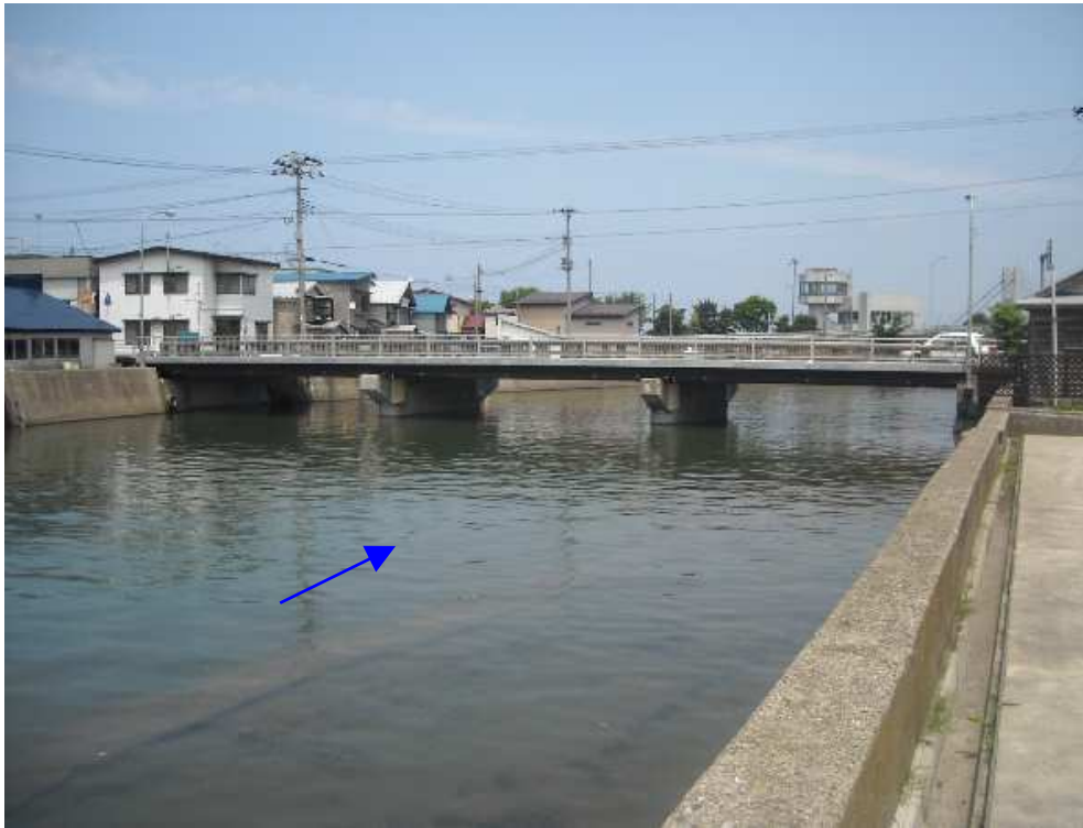
①明海橋:改修前
