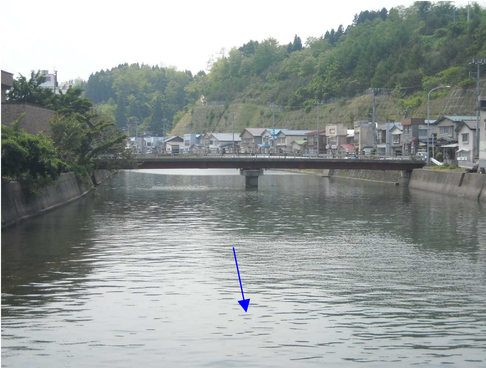
①舞戸橋:改修前
