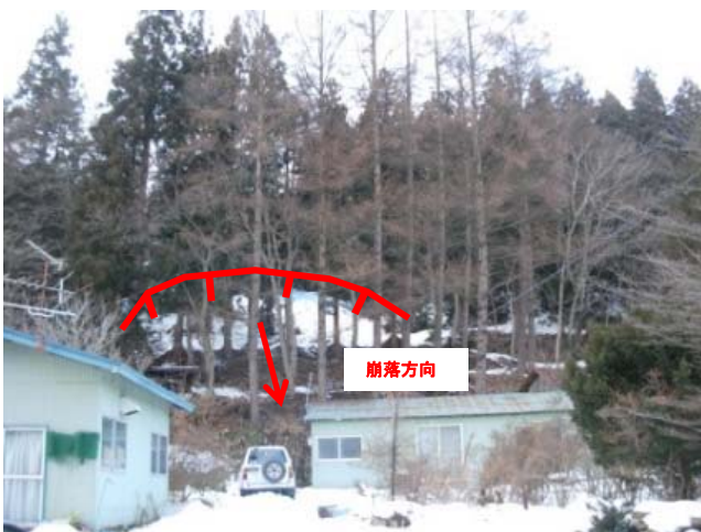
No.10付近の小崩落状況
