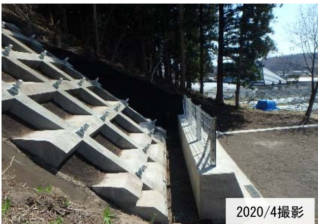
全景写真(施工起点側NO.16から) 事業実施区間
