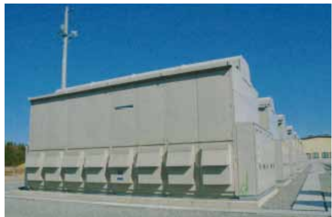
図2-5 二又風力発電所NAS電池外観
