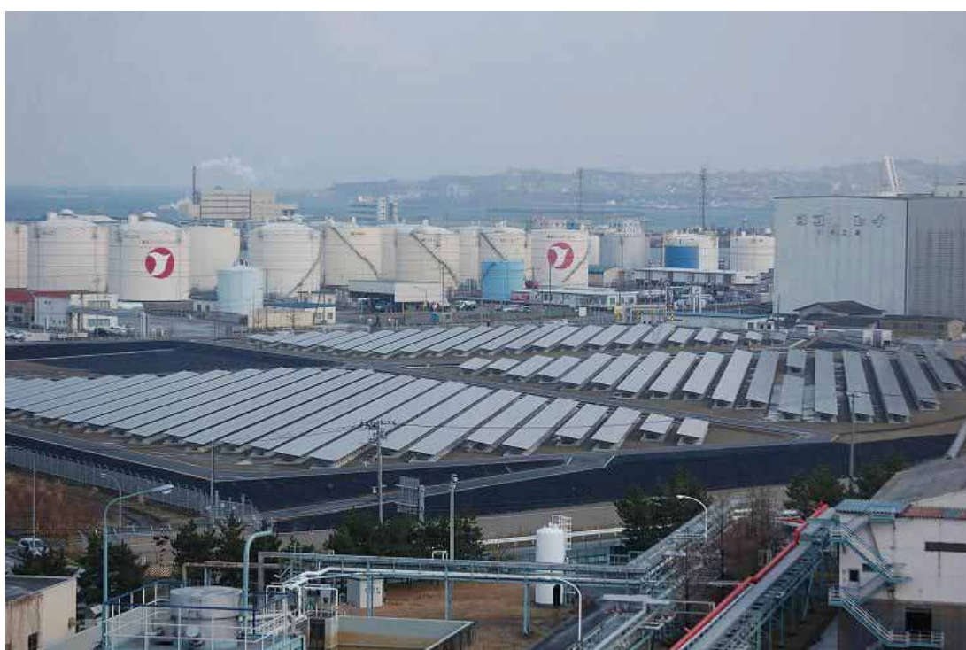
図2-2 八戸太陽光発電所の完成外観
