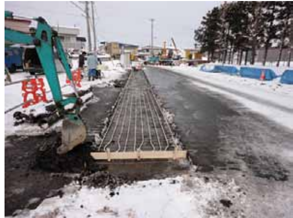
図2-13 パイプ敷設施工例
