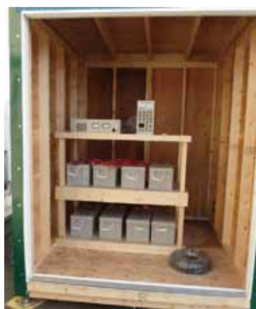
図2-40 北日本新エネルギー研究所屋上設置鉛蓄電池と測定盤等
