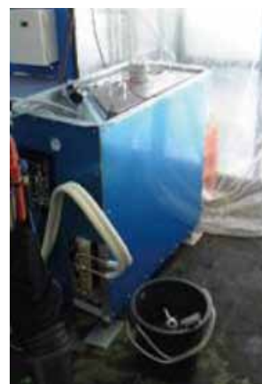
図2-18 地中熱交換タンク
