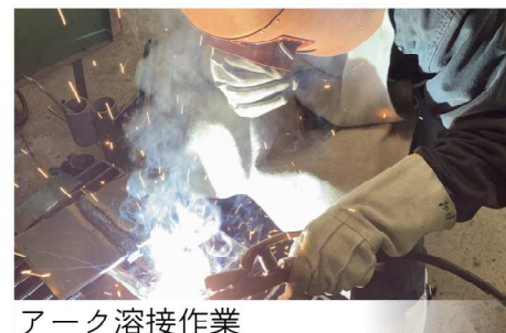
アーク溶接作業
