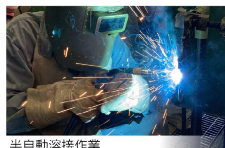
半自動溶接作業
