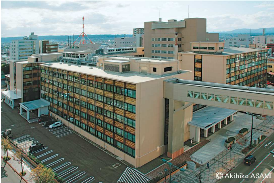
工事の状況 R1.10.26撮影
