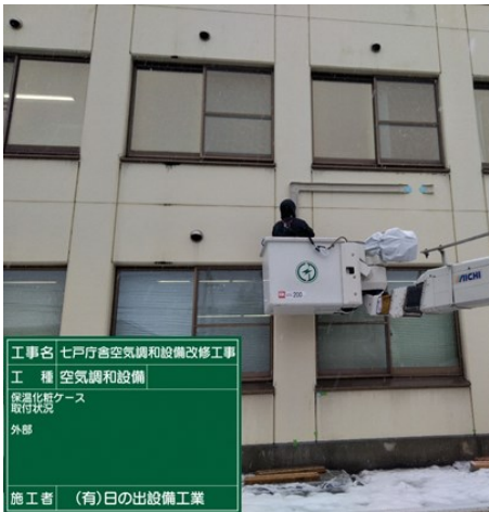
外部配管状況
