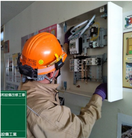
電気工事状況
