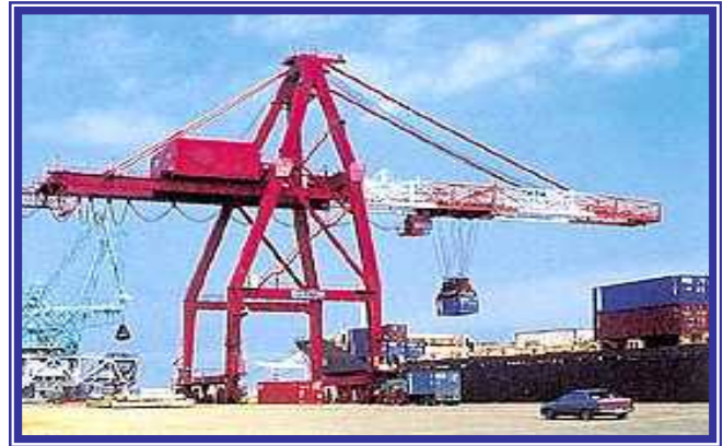
【八戸港コンテナ岸壁】
